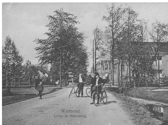
De Herenweg ter hoogte van Albert Heijn, rechts, toen nog de Nicolaasschool, en aan beide zijden van de Herenweg sloten
